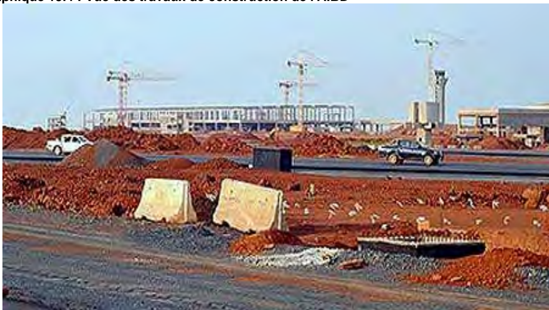
Graphique 15.4 : Vue des travaux de construction de l'AIBD
