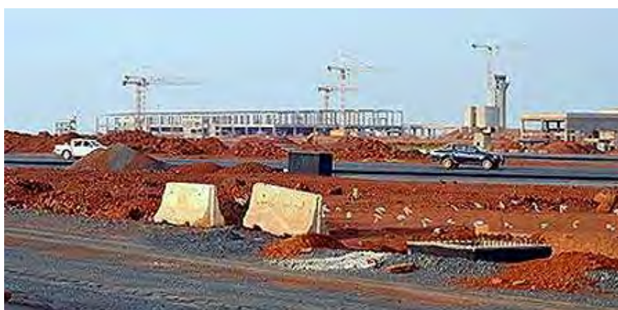
Figure 2: Vue des travaux de construction de l'AIBD 52
